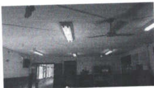
BLOCO 16 – 2º pavimento
