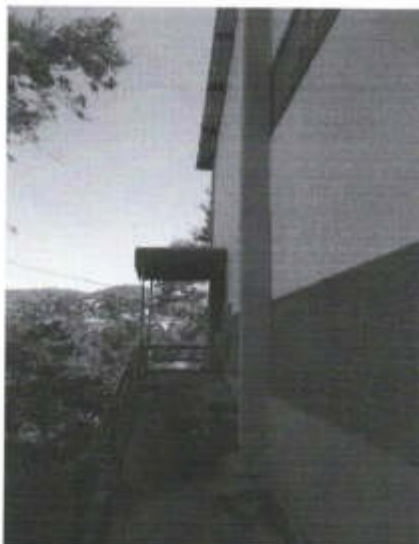
Bloco 18 – utilização de sua cobertura existente para a montagem de parte do Sistema Fotovoltaico.
