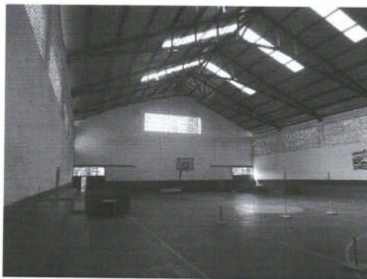
Bloco 18, interna do Ginásio, indicado todo telhado apoiado sobre estrutura metálica.
