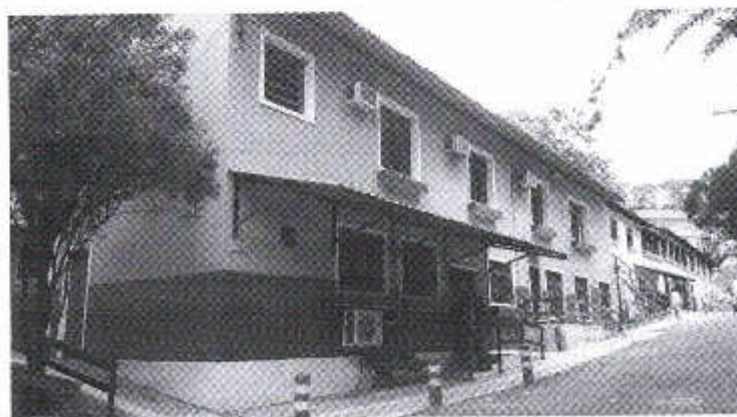
Fachada frontal da via principal, uma das águas da cobertura existente.
