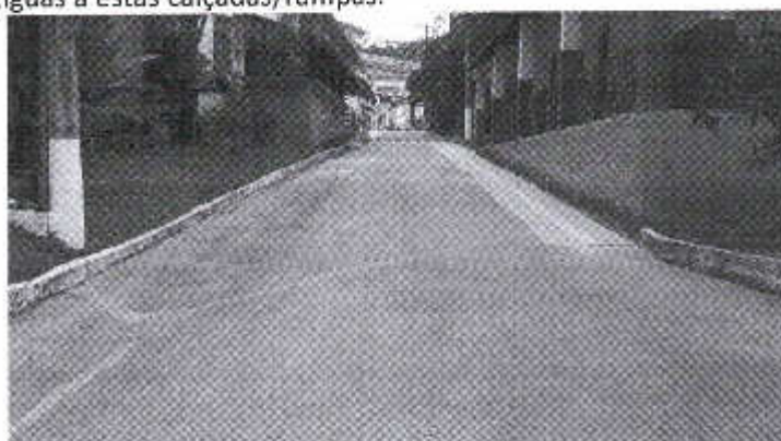
Foto da Via de Acesso, à esquerda, o Bloco 7, e à direita, da extremidade do Bloco 8.
