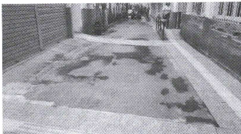
Via de acesso, COM VISÃO PARA O FINAL DA VIA, à esquerda ainda o Bloco 12, local da cantina - à direita o Bloco 13/17.
