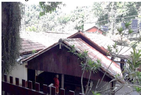
Visão das águas do telhado.
