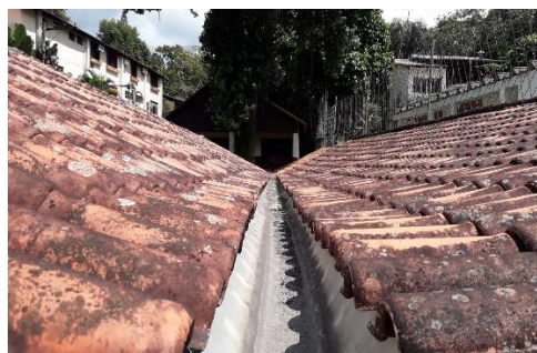
Vista da calha interna existente, entre as duas águas
