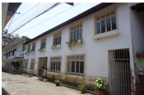
Reforma no pavimento superior deste prédio Vista da fachada do prédio 17.
