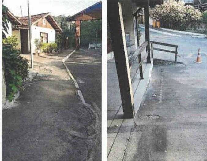
Fotos 1 e 2 - A esquerda, calçada existente, à direita trecho para ser executada calçada, alinhando pela construção.
