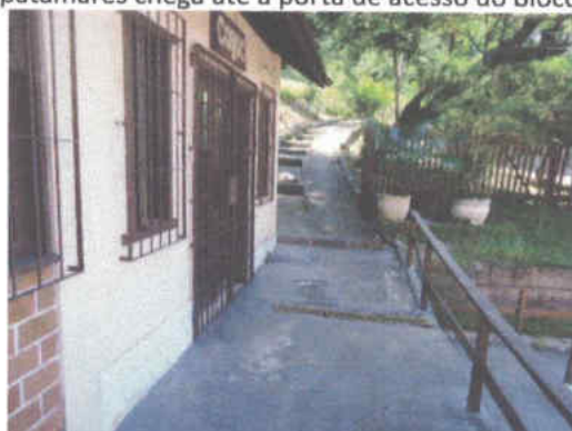
Foto 38 – porta de entrada do bloco 5 em seu 1º pavimento, e na sequência a rampa existente que terá destino no bloco 18, o Ginásio, com percurso de 45 metros, logo após o alinhamento do último degrau (nesta foto, a esquerda na parte superior – ver também em planta – prancha 4/4;
