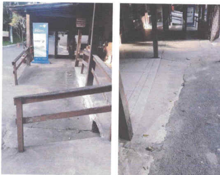
Fotos 3 e 4 - Alinhando pela construção (limite de sua varanda interna) até a outra extremidade.
