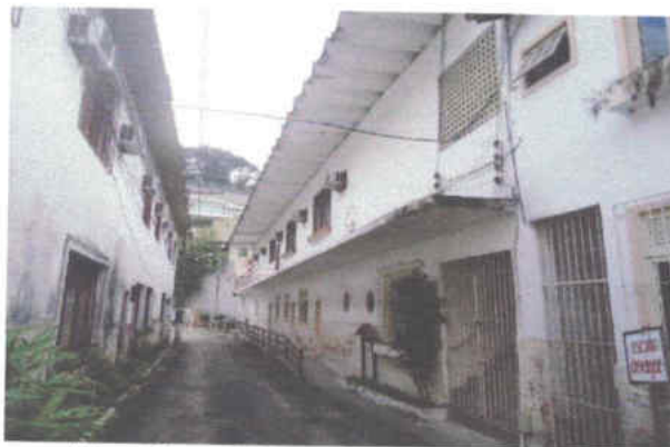
Foto 20 – 1ª grade a direita acesso bloco 17 serviço e a seguir a rampa ao longo do bloco 17.
