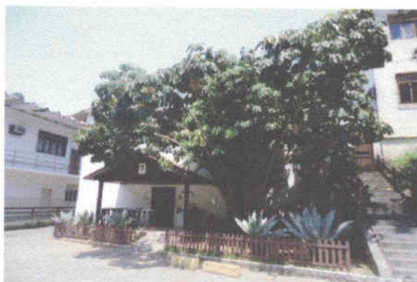
Foto 22 – frente do bloco 16, com a calçada vindo do bloco 17 e passando a sua frente, com acesso a varanda coberta. O percurso do Trecho 7 prosseguirá ao longo do bloco 15, conforme foto abaixo.
