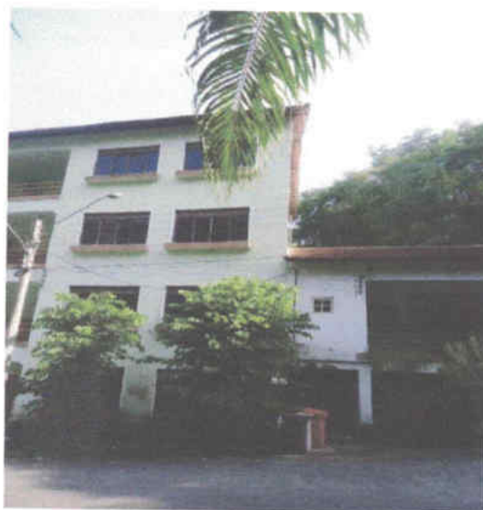
Foto 34 – a calçada prosseguindo passando da lateral do bloco 14 para o bloco 19.
