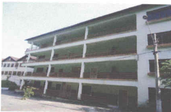
Foto 33 – lateral do bloco 14, neste vão de acesso ao 1º pavimento, o trecho 9 de calçada iniciando.
