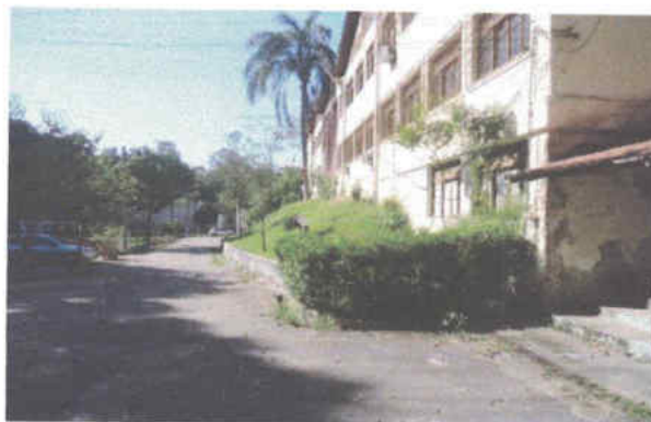
Foto 24 – extremidade do bloco 15. Cobertura lateral.
